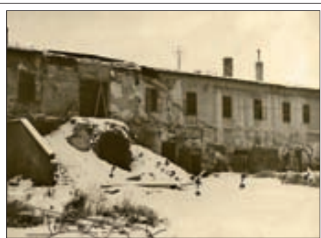
ČASŤ HLAVNEJ (JUŽNEJ) FASÁDY SEVEROZÁPADNÉHO TRAKTU, R. 1968
