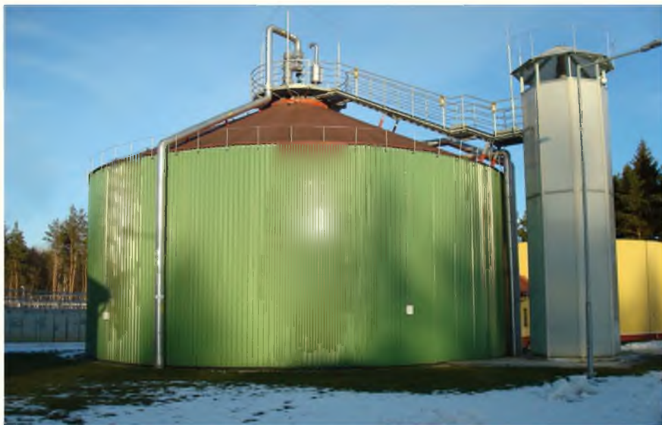
Vyhňivacia veža v rámci ČOV Námestovo Wieża fermentacyjna w oczyszczalni Námestovo
