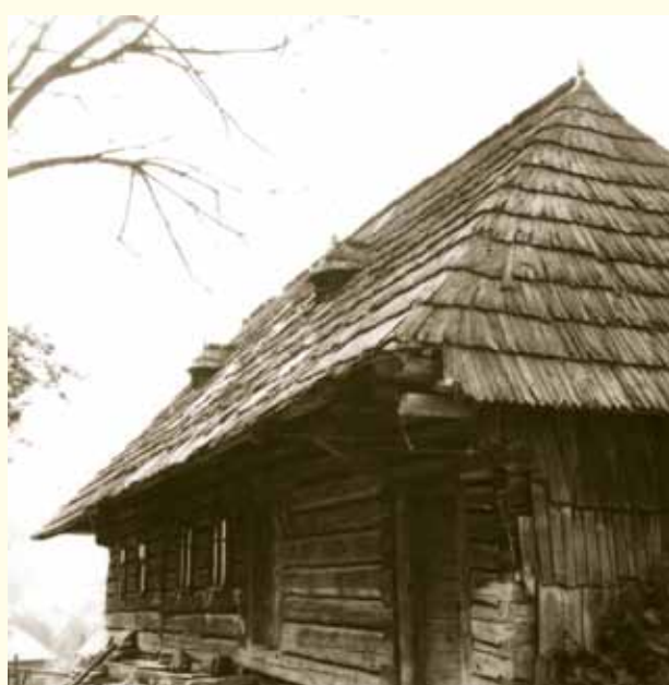
Dym bol zo strešného priestoru drevenice odvádzaný tzv. dymníkmi, ktoré boli umiestnené na streche. Oravské Veselé. 1. polovica 20. storočia.
