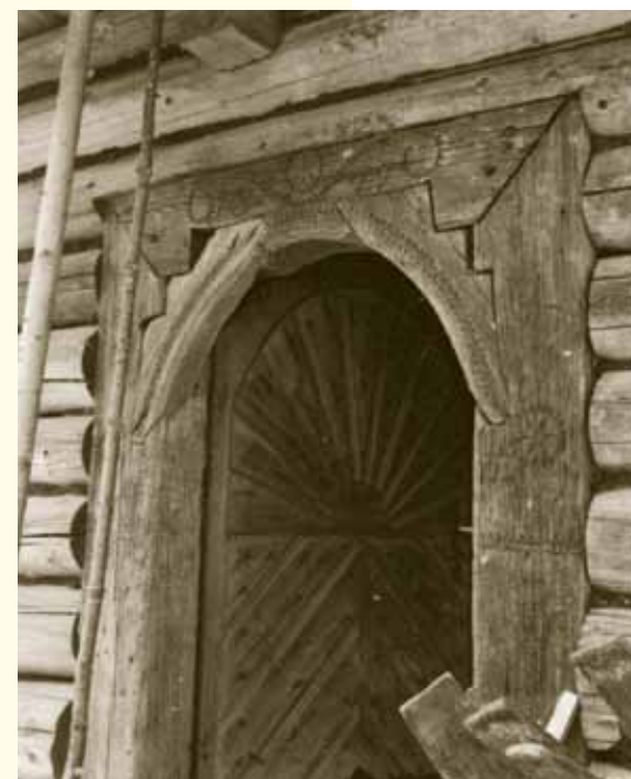
Vyrezávaný portál vchodových dverí. Novot'. 1. polovica 20. storočia.
