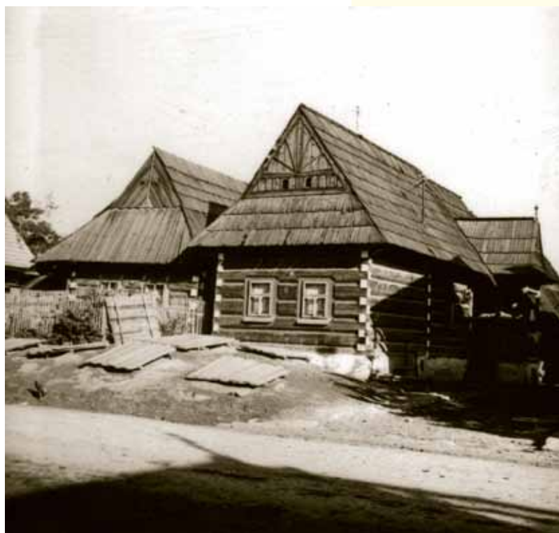
Drevená architektúra v popredí s doštenými strieškami na zemi, ktoré prikrývali zemiakové jamy. Suchá Hora. 1. polovica 20. storočia.
