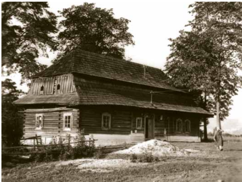
Dom šoltýsa s podkrovnými komorami. Rabčice. 1. polovica 20. storočia.
