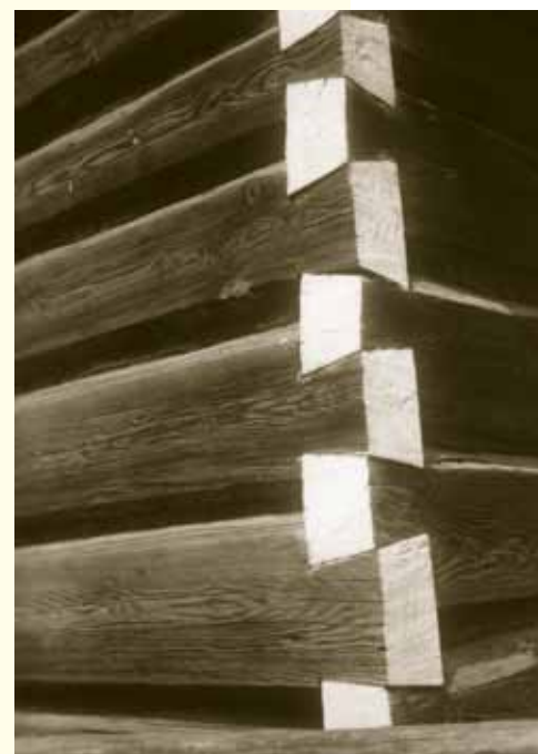
Viazanie dreveného zrubu na tzv. „rybinu“. Suchá Hora. 1. polovica 20. storočia.
