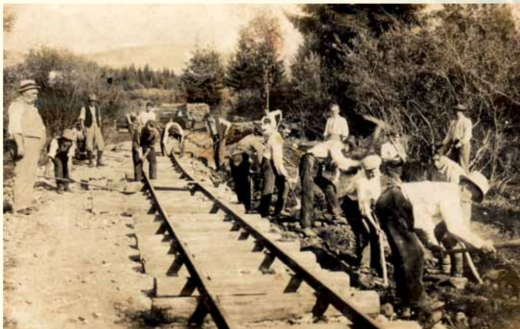
Stavba trate v Mútnom, 1929 - 1930.
