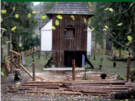
110. Rekonštrukcia zvonice a ploty, 2007
