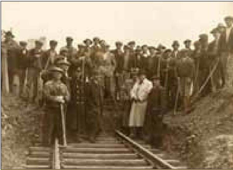
Stavba železničnej vlečky
